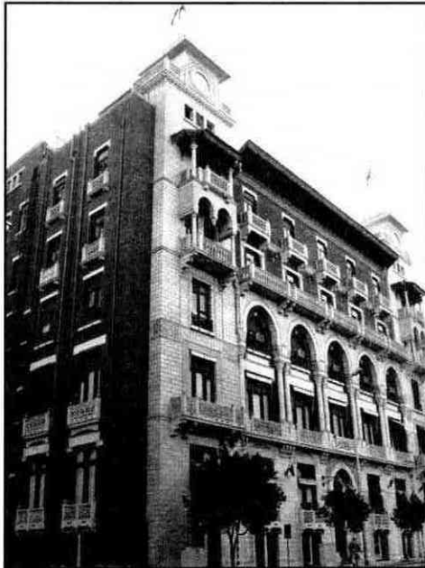
المبنى الرئيسي للبنك
